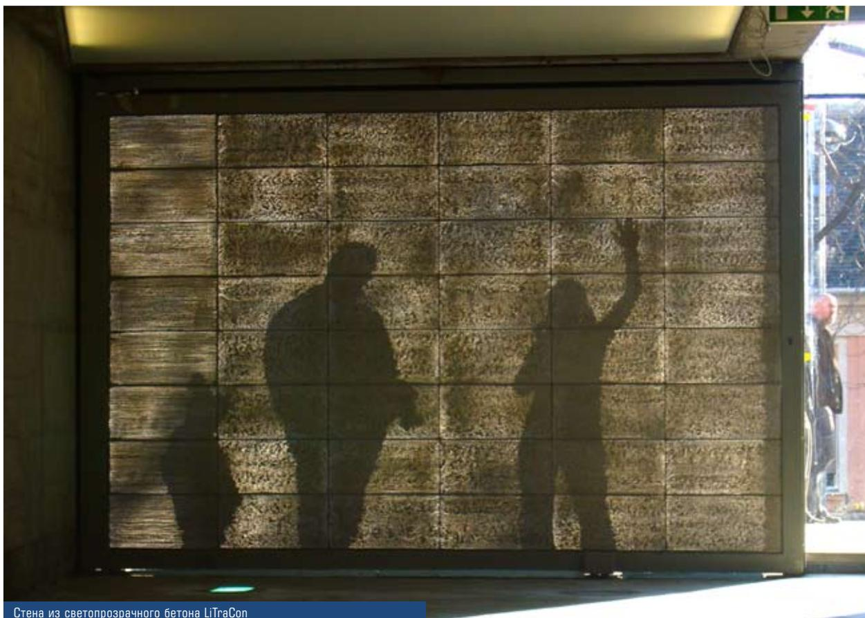
Стена из светопрозрачного бетона LiTraCon
